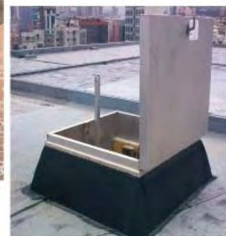
城市花園改建工程
