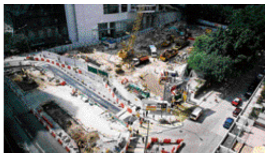
堅尼地城站的樁柱建造工程
